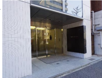
■エントランス (外側)
