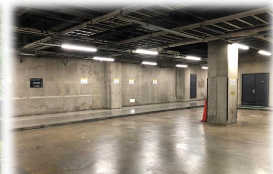
地下荷捌き場
